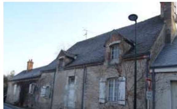
Bâtiment R + combles avec toiture en tuiles plates de pays, lucarnes et corniche en briques
