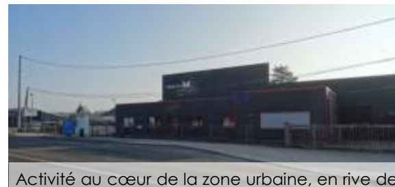
Activité au cœur de la zone urbaine, en rive de la RD 951.
